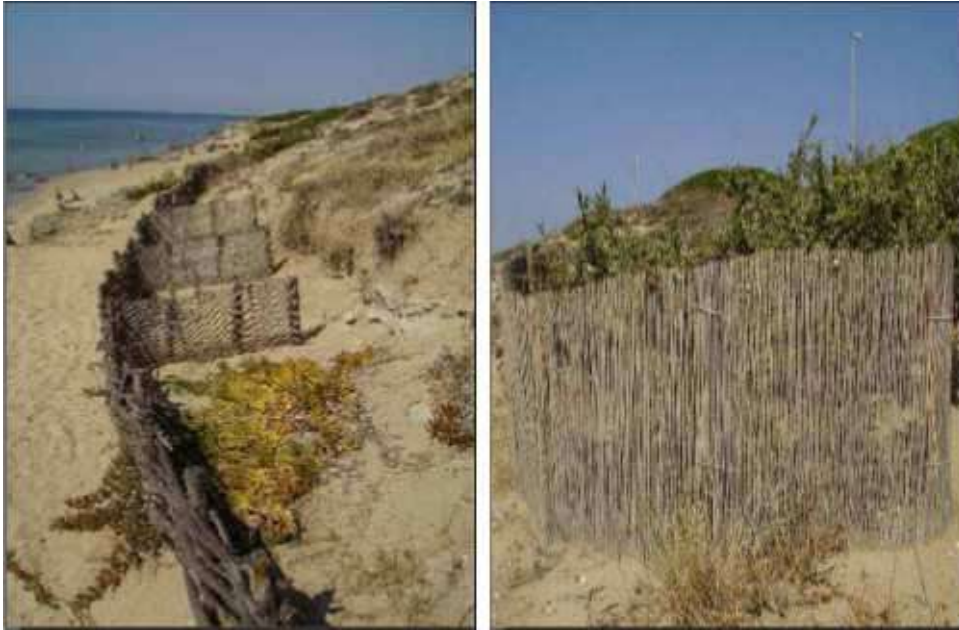
Imm. 33: Intervento di ripristino della vegetazione dunale di Campomarino, Schermi frangivento a protezione della vegetazione di nuovo impianto (Foto L.Onori – ISPRA – 2008 – da Repertorio nazionale degli interventi di ripristino - Scheda 6b – Puglia – Intervento di ripristino della vegetazione dunale di Campomarino ( http://www.isprambiente.gov.it )).
