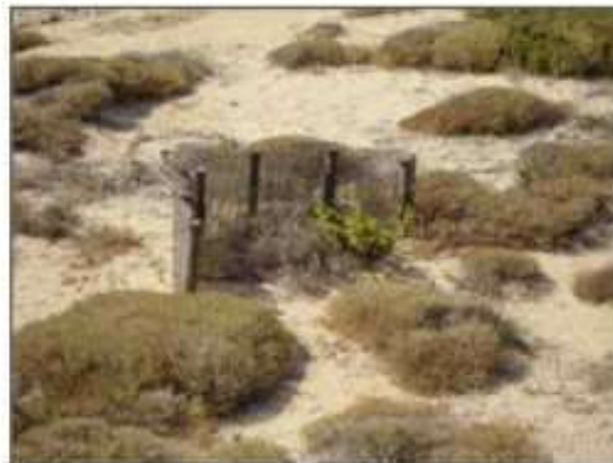
Imm. 34: Intervento di ripristino della vegetazione dunale di Campomarino, Schermi frangivento a protezione della vegetazione di nuovo impianto, viminate basali, tessuto non tessuto e chiudenda in legno a protezione delle dune (Foto L.Onori – ISPRA – 2008 – ibidem).
