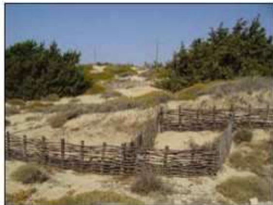
Imm. 34: Intervento di ripristino della vegetazione dunale di Campomarino, Schermi frangivento a protezione della vegetazione di nuovo impianto, viminate basali, tessuto non tessuto e chiudenda in legno a protezione delle dune (Foto L.Onori – ISPRA – 2008 – ibidem).
